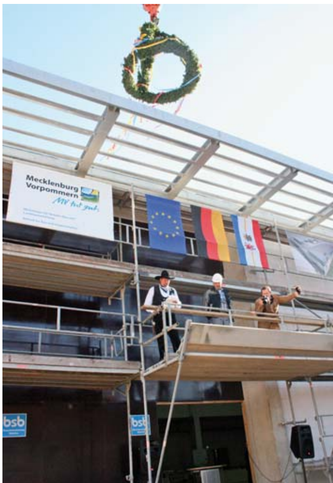
Am 13. Oktober 2011 wurde Richtfest gefeiert.
