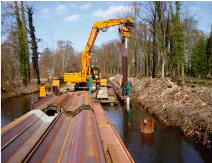
Spundwand an der MEW/Bauschpark
