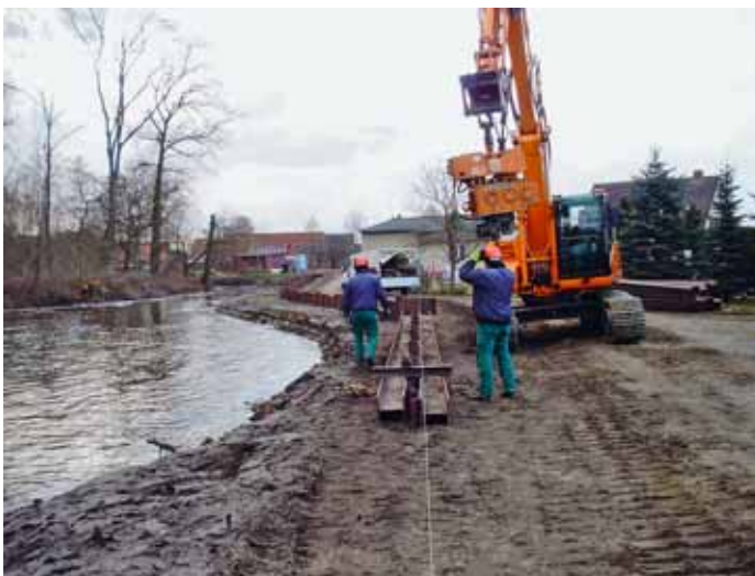
Rammung der Spundwand in Heiddorf
