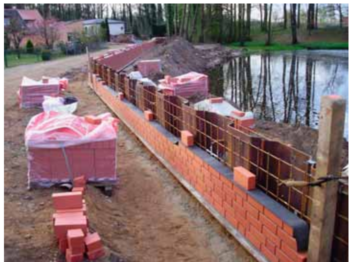
Verklindern der Spundwand in Heiddorf
