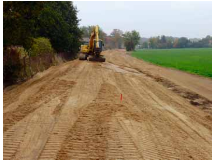
Deichbau auf ehemaligen Bahndamm
